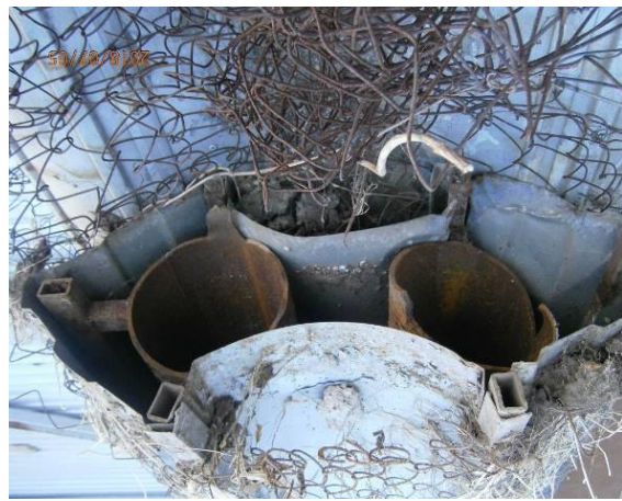
Рисунок 4. Відповідна частина зруйнованої рекламної конструкції
