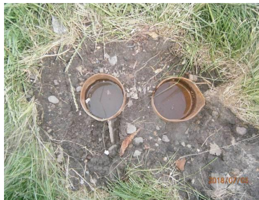
Рисунок 2. Руйнування опор рекламної конструкції вид зверху
