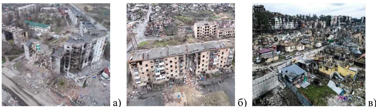
Рисунок 1. Приклади фотофіксації зруйнованих і пошкоджених об'єктів Київської області: Бородянки (а); Горенки (б); Ирпеня (в)
